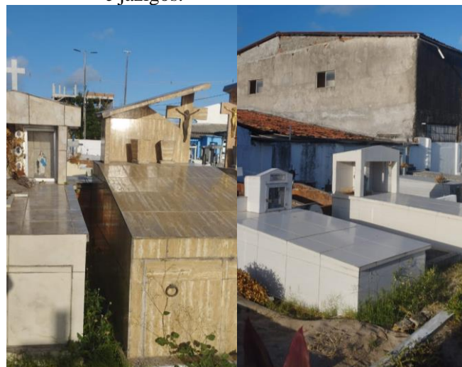
Figura 4 – Não cumprimento da Resolução nº 368/06 quanto a distância entre os jazigos e a parte externa do cemitério; Distâncias variadas (15 a 35cm) entre os passadiços de túmulos e jazigos.
